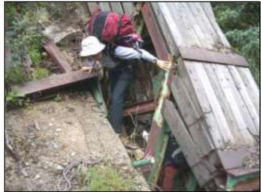
水口に下りる階段。鉄骨で囲んであるのに雪のためか崩れ、これ以上下りられない
